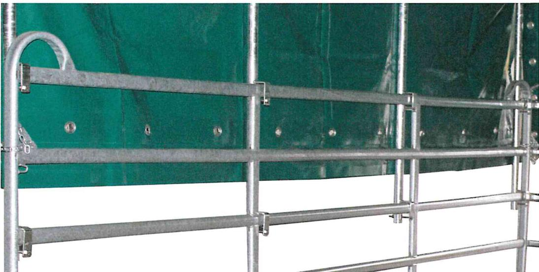
5. Nun die 3 Flacheisen **E** gerade (*am First außermittig*) und die 4 Flacheisen **F** diagonal auf den Dachbügeln anbringen und an jedem Dachbügel mit jeweils 4 Schlossschrauben **I** befestigen.
